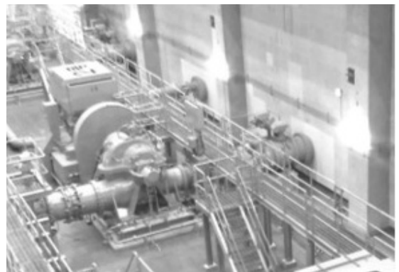
Fig. 2 送水ポンプ設備向け両吸込渦巻ポンプ
