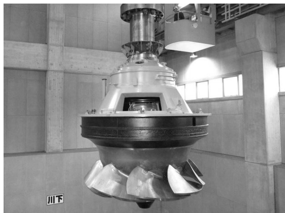
Fig. 6 西勝原第三発電所 ランナ吊込み
