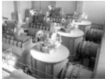
図5 口径1,500 mm立軸軸流ポンプ(鶴見)
