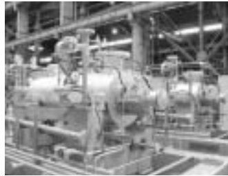
図3 バレル型ボイラ給水ポンプ(西島)
