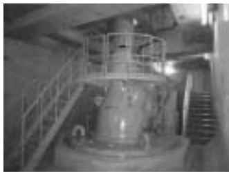
図2 排水機場用立軸斜流ポンプ (鶴見製作所)
